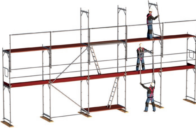
Bild 30: Montage der Gerüstlage im Schutze des MSG.
