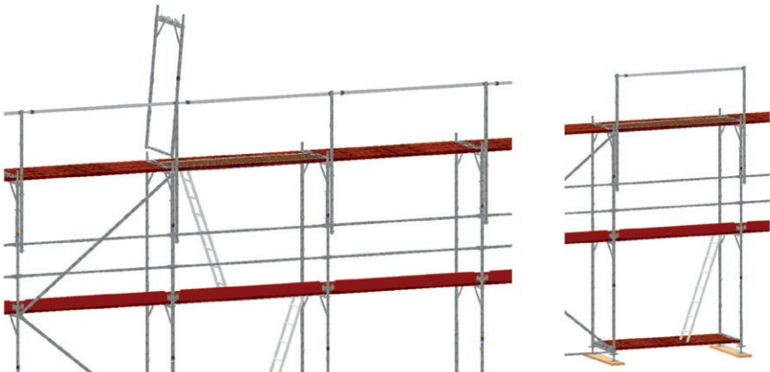
Bild 31: Aufstecken eines Vertikalrahmens.
