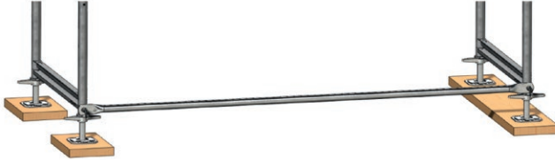
Bild 7: Aufbau des ersten Gerüstfeldes: Längsriegel
