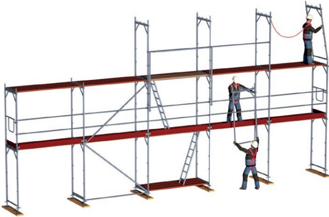
Bild 35: Montage im Schutze der PSAgA auf der obersten Gerüstlage.
